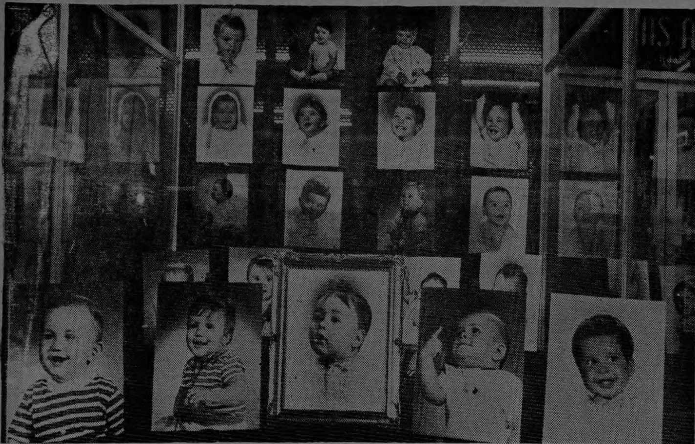
UN ESTUDIO FOTOGRAFICO QUE ENGALANA SAN JOSE.— El "Studio Suzanne" propiedad de don Manuel Vilchez y ubicado en la Avenida Central es un establecimiento que con su moderna instalación y sus bien presentadas vitrinas, que son verdaderas galerías de arte fotográfico, dan a nuestra ciudad
